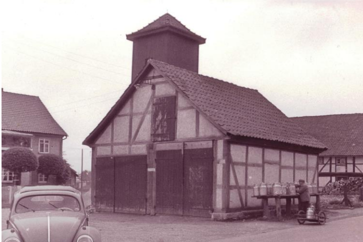
Das alte Feuerwehrgerätehaus in der Holtenser Straße
