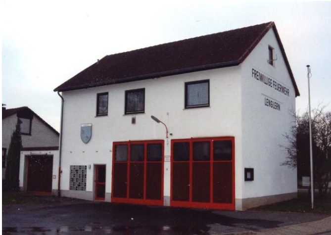
Feuerwehrgerätehaus von 1989 bis 2000
